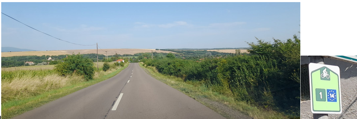
2404 sz. út Rózsaszentmárton felé Apc felől (balra a tervezett kerékpárút helye) és a kerékpáros útvonal jelenlegi jelzése
